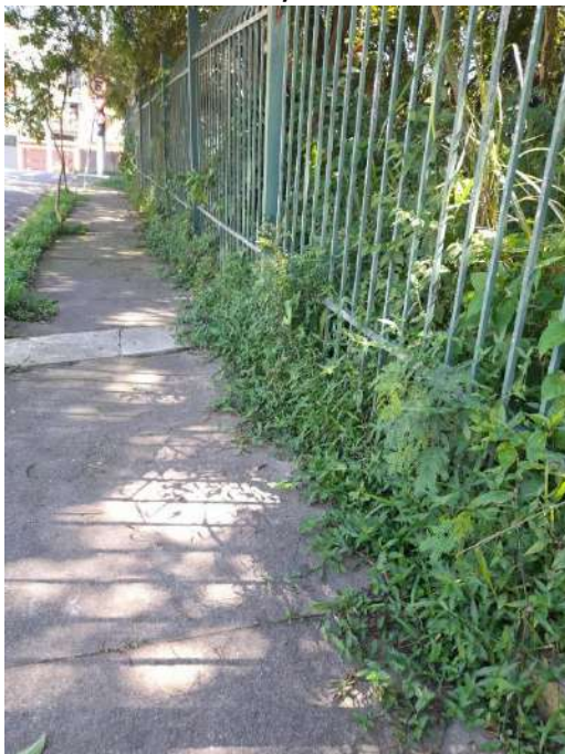
FIGURA 16: LIMPEZA E DESPRAGUEJAMENTO GRADIL, ANTES.
