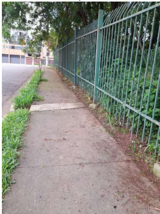
FIGURA 17: LIMPEZA E DESPRAGUEJAMENTO GRADIL, DEPOIS.
